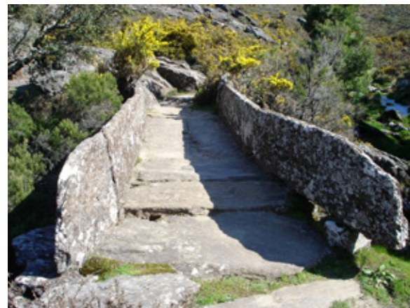
Ponte das Traves (Arga de Baixo, Caminha)
