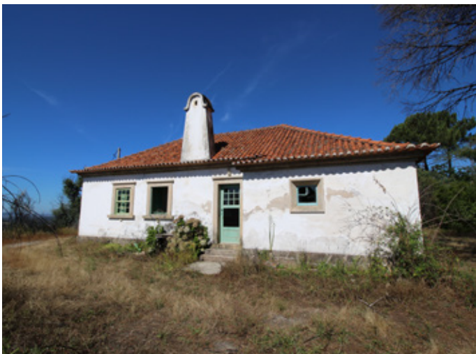
Figura 70. Antiga casa florestal de Sangemondes, Ponte de Lima
