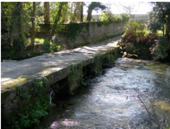
Ponte da Torre (Âncora/Riba de Âncora)
