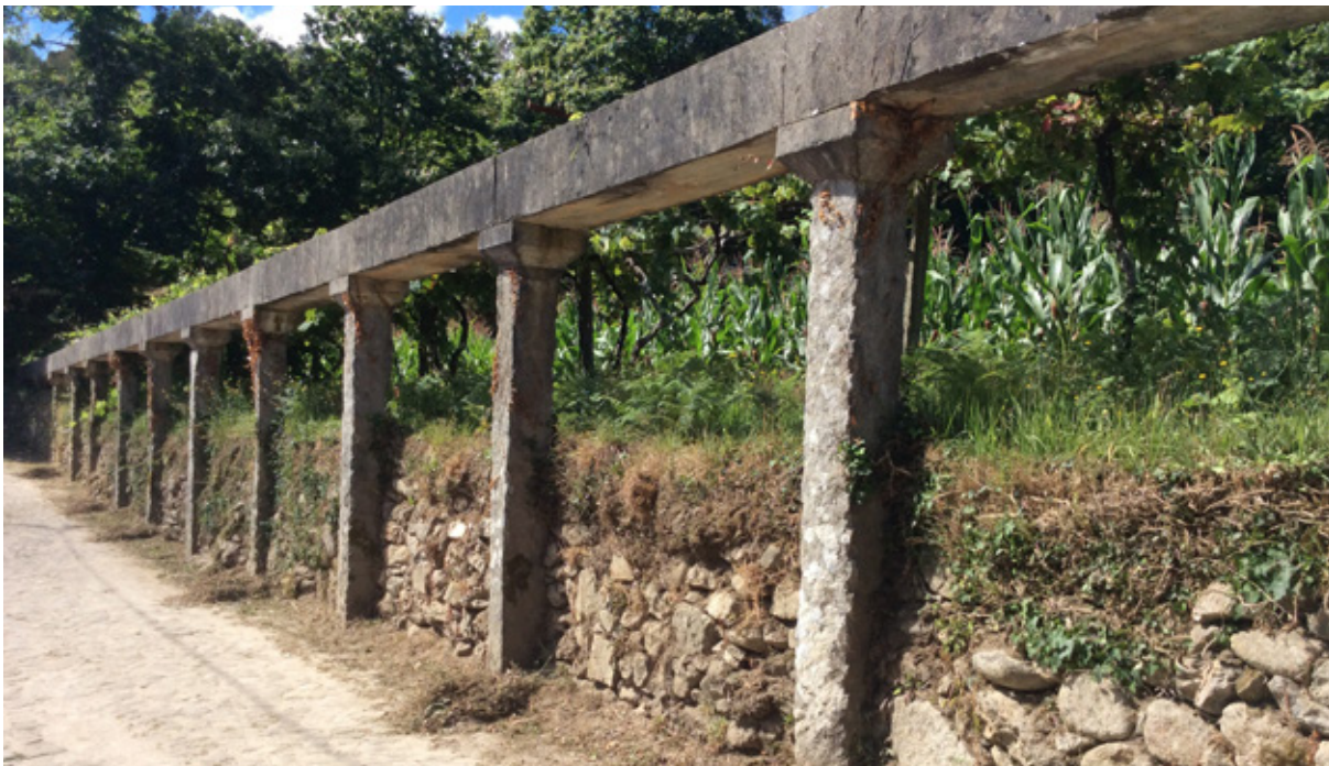
Levada em aqueduto
