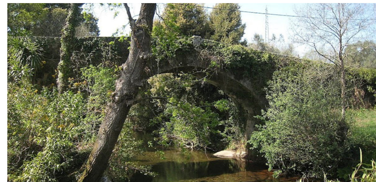
Figura 35. Ponte de Abadim (Vila Praia de Âncora)
