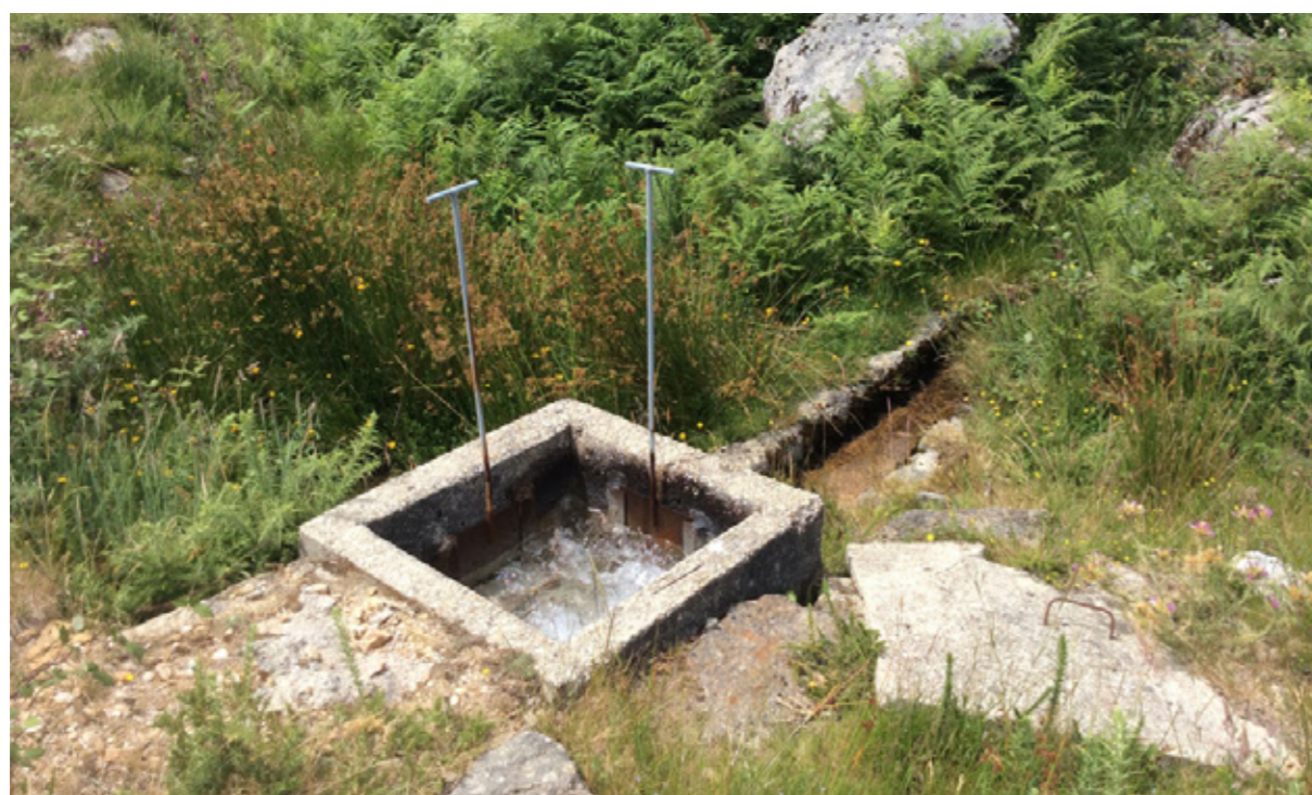
Figura 166. Sistema de controlo das águas de rega
