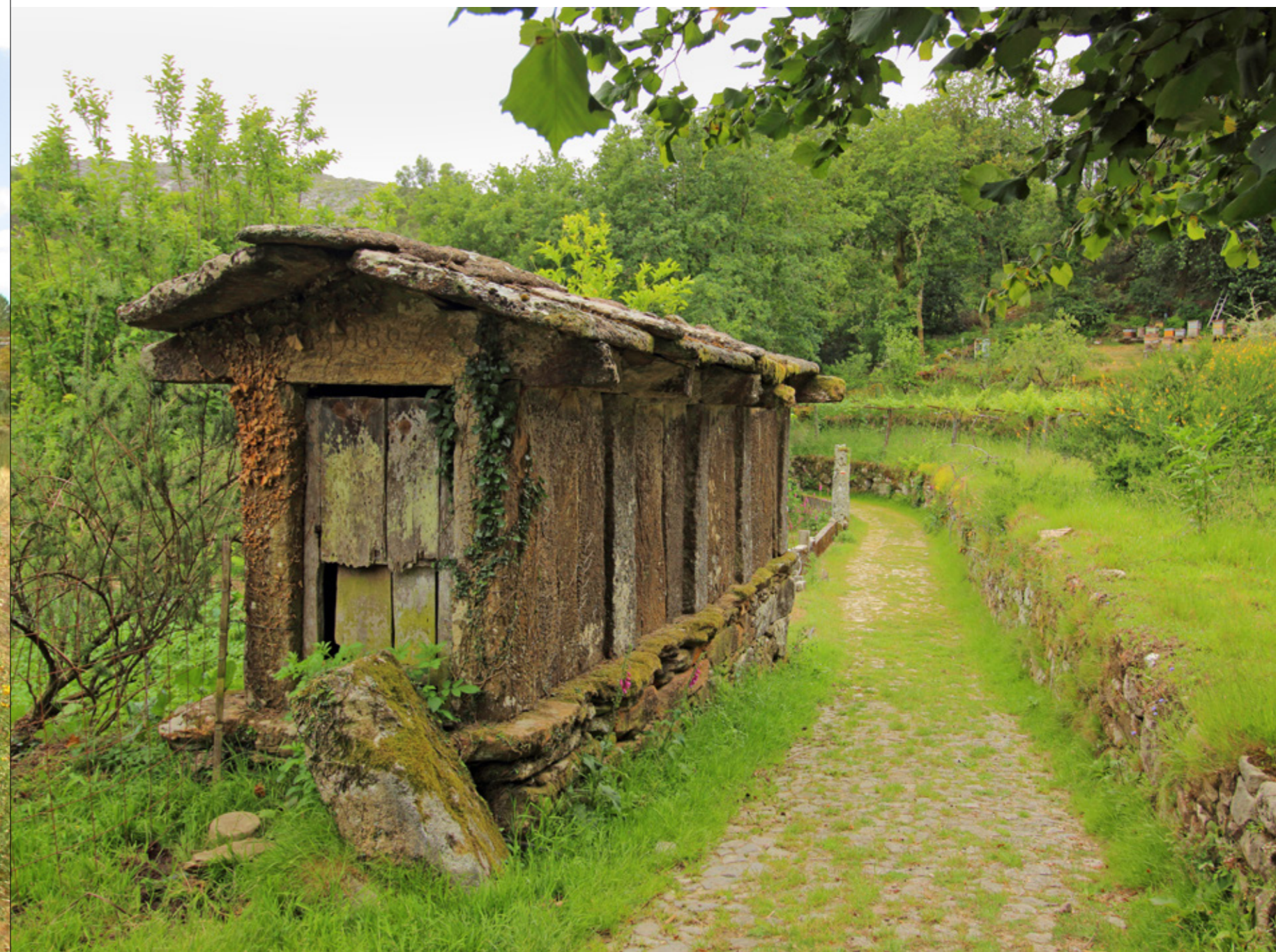
Figura 152. Espigueiro sobre muro de vedação
