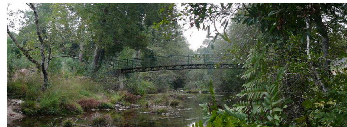
Figura 36. Ponte metálica do Cais (Freixeiro de Soutelo)
