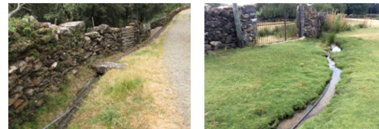
Figura 143. Levadas em rego cavado
