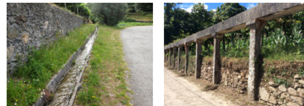
Figura 144. Levadas em canal e em aqueduto
