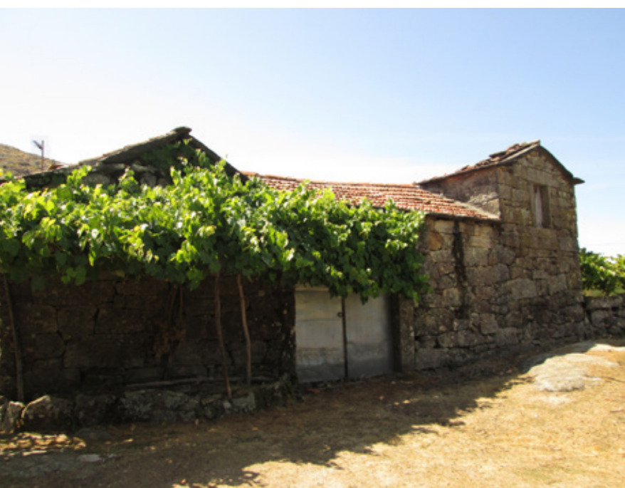
Figura 146. Muro de vedação do quintal da Casa da Eirinha (Arga de Baixo)
