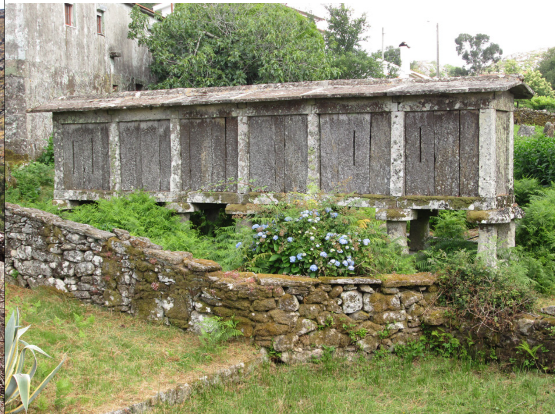
Figura 154. Espigueiro da Casa da Pontelhinha (Arga de Baixo)
