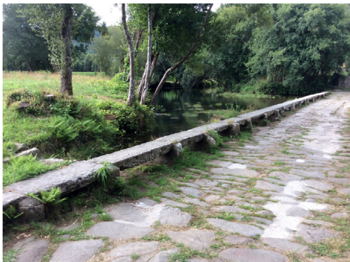
Figura 37. Pontão da Tábua (Freixieiro de Soutelo)
