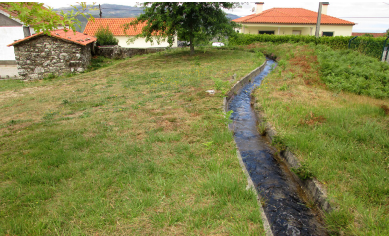
Figura 43. Levada em canal semienterrado.
