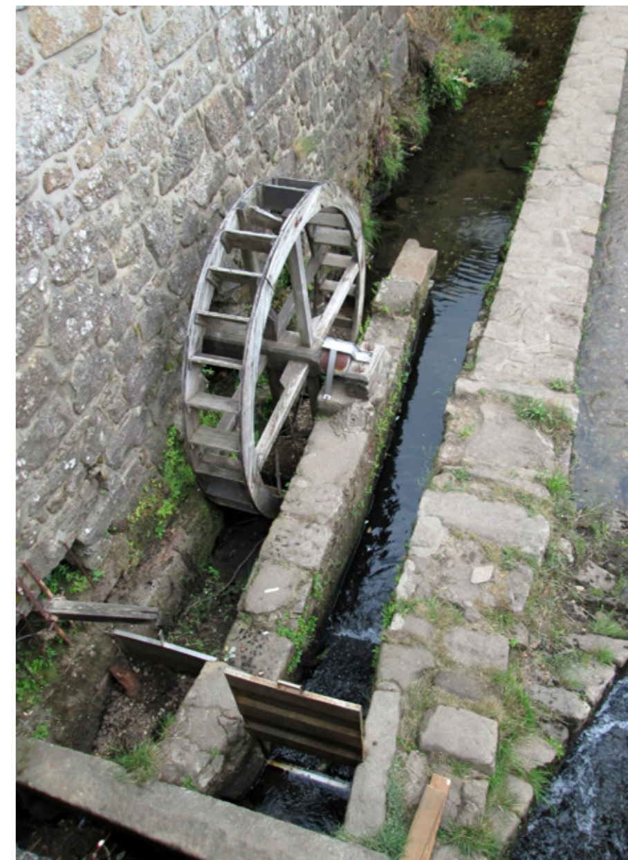
Figura 46. Roda vertical de madeira da Azenha da Ponte de Estorãos
